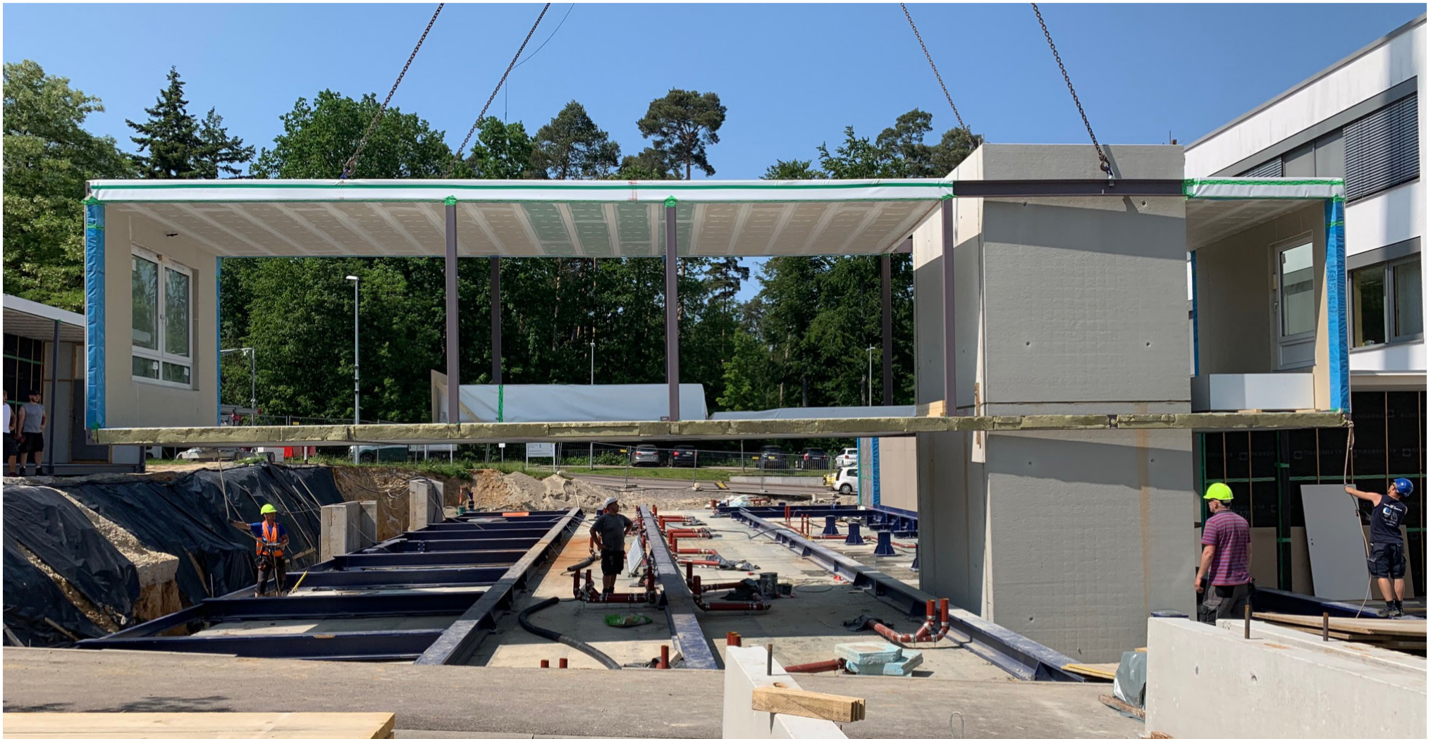
Aufstellung der Module des Interimsbaus
